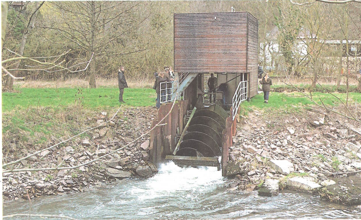
Die Ernst Malzfeldt KG betreibt ein großes Wasserkraftwerk an der Diemel in Bad Karlshafen. Dazu gehört diese Wasser-schnecke (22 kW), die überschüssiges Wasser aus dem Zuleitungsgraben nutzt (ein ausführlicher Bericht dazu folgt).
