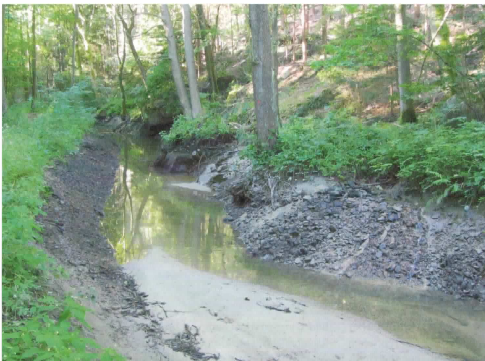
Bild 1: Obergraben der WKA Elbersdorfer Mühle während einer betriebsbedingten Absenkung (Quelle: Weiß)
