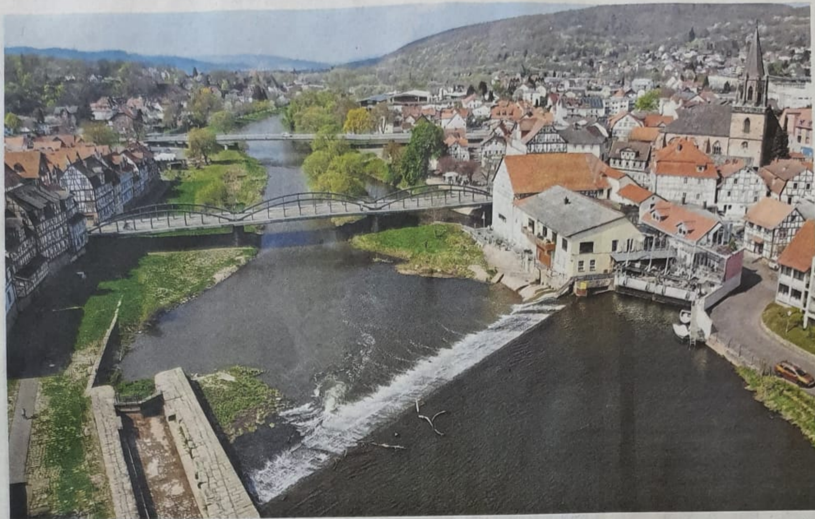
Das Rotenburger Wasserkraftwerk Haag produziert Energie aus Fuldawasser – hier zu sehen rechts neben dem Wehr. Eine Gesetzesänderung könnte zur Folge haben, dass die Turbinen bald stillstehen. FOTO: CONNY HAAG-LORENZ/NH
