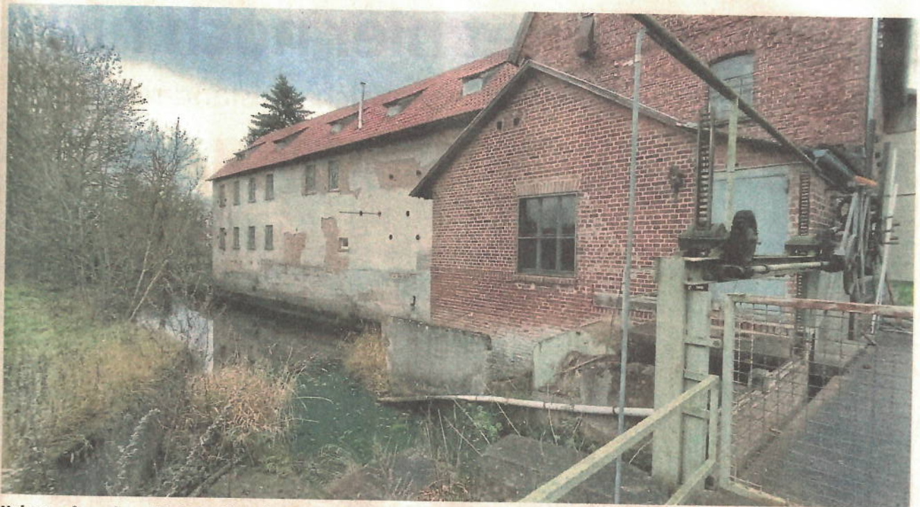
Haben aufgegeben: Die Betreiber des Kleinkraftwerkes an der Obermühle in Reichensachsen haben ihre Wasserrechte zurückgegeben, die Stromerzeugung wird bei einer Renaturierung der Wehre unrentabel.
