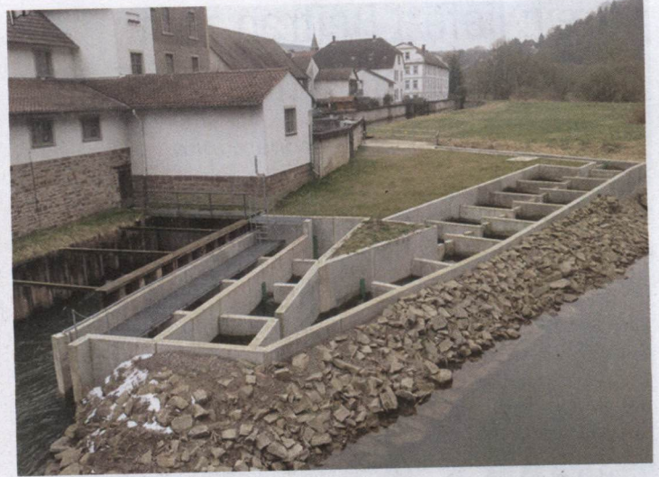
Fischen sollte es ermöglicht werden, Wasserkraftanlagen zu passieren. Dies kann beispielsweise mit einem sogenannten Fischaufstieg geschehen. Fotos: Heldmann
